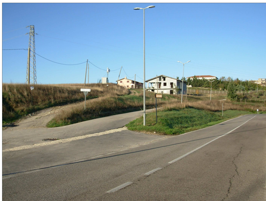
Figura 6: Vista accesso all'area sud dalla S.S. n.212
