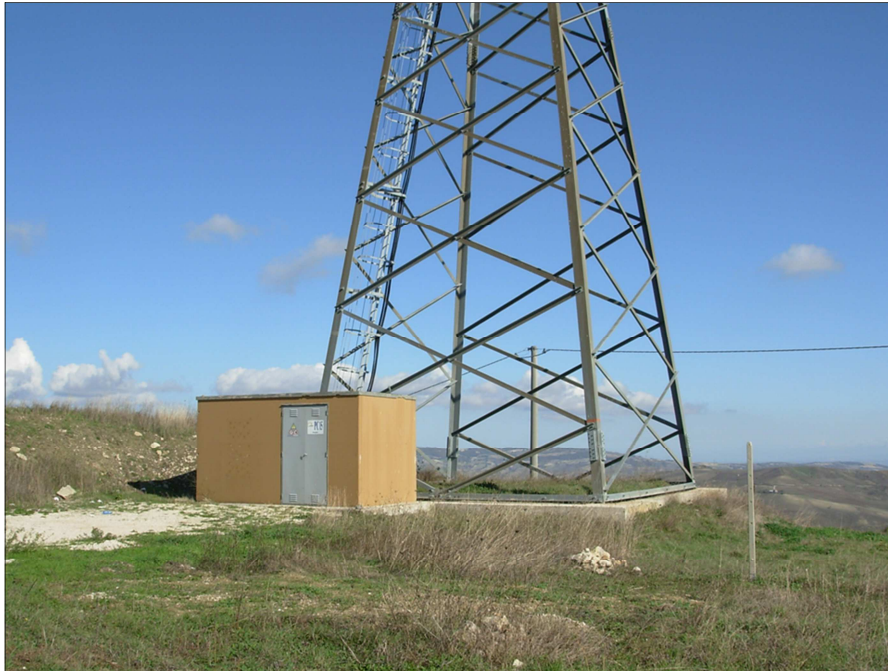
Figura 8: Dettaglio postazione aerogeneratore esistente con la relativa cabina di macchina
