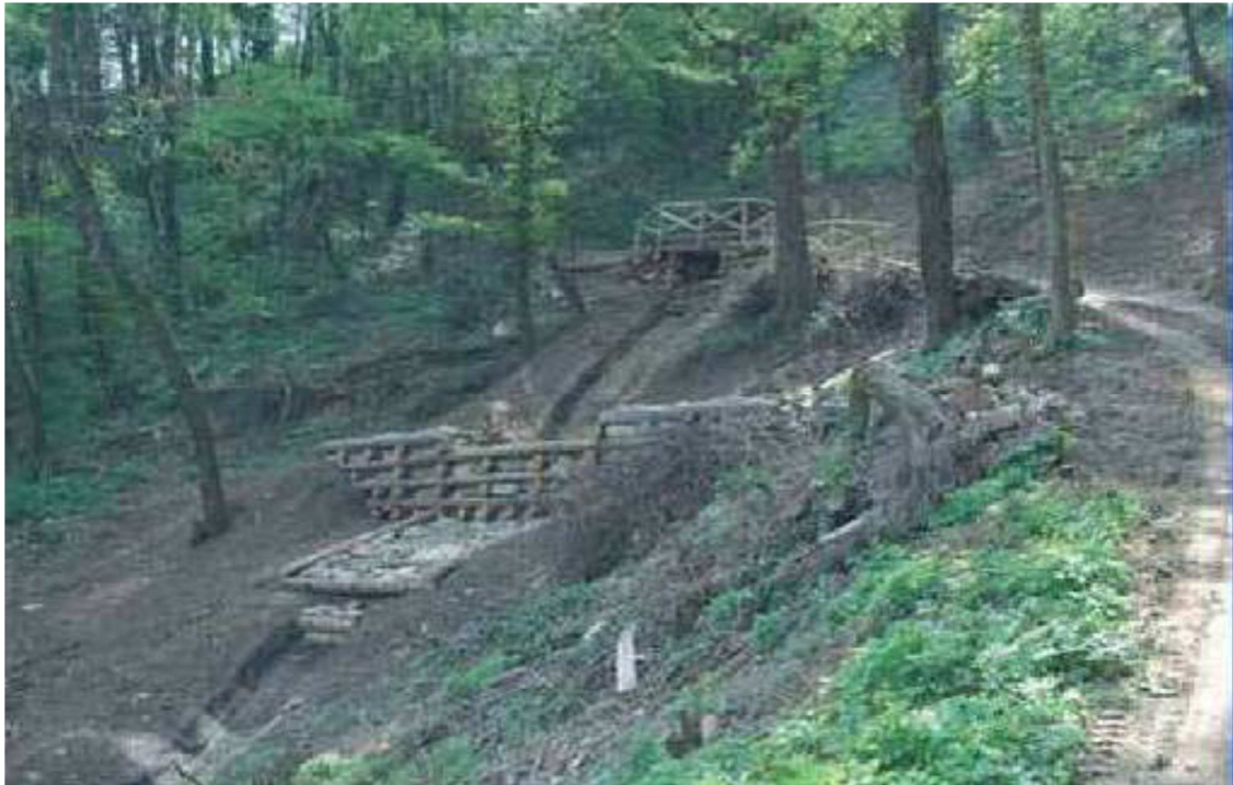
Figura 23: Esempio di briglie in legname e pietrame.
