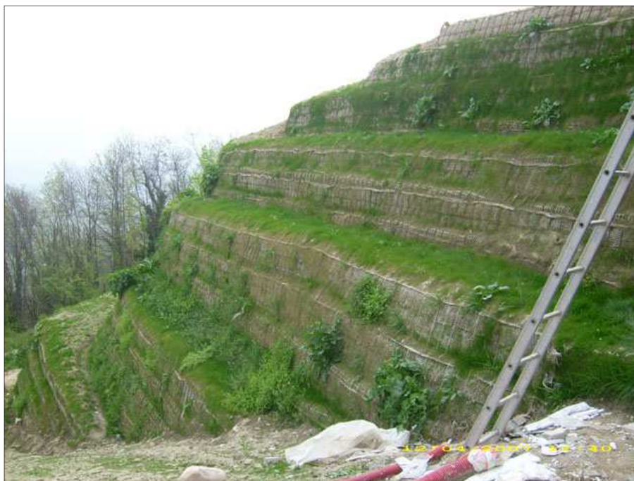
Figura 19: Esempio di rilevato in terre rinforzate.
