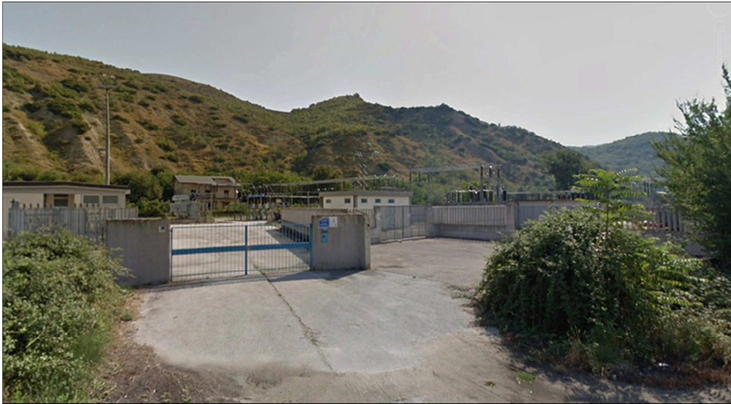
Figura 26: Sulla destra la sottostazione elettrica ERG; sulla sinistra la cabina primaria E.Distribuzione.
