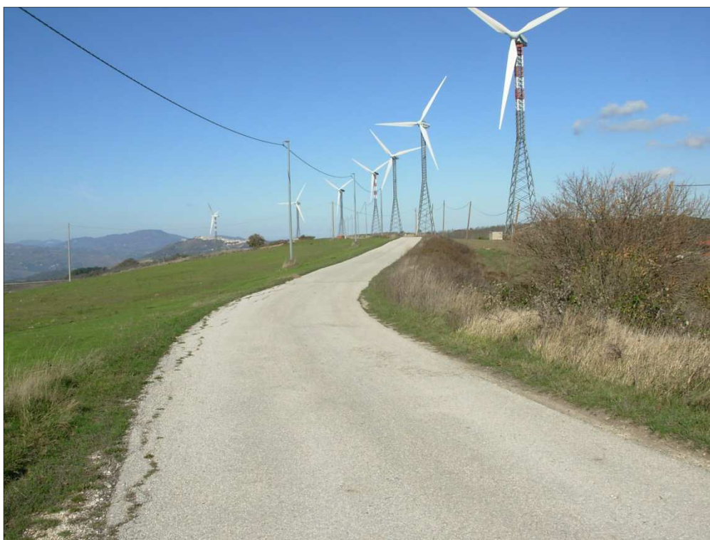
Figura 1: Vista dell'area nord del sito, crinale sviluppo direzione nord-ovest
