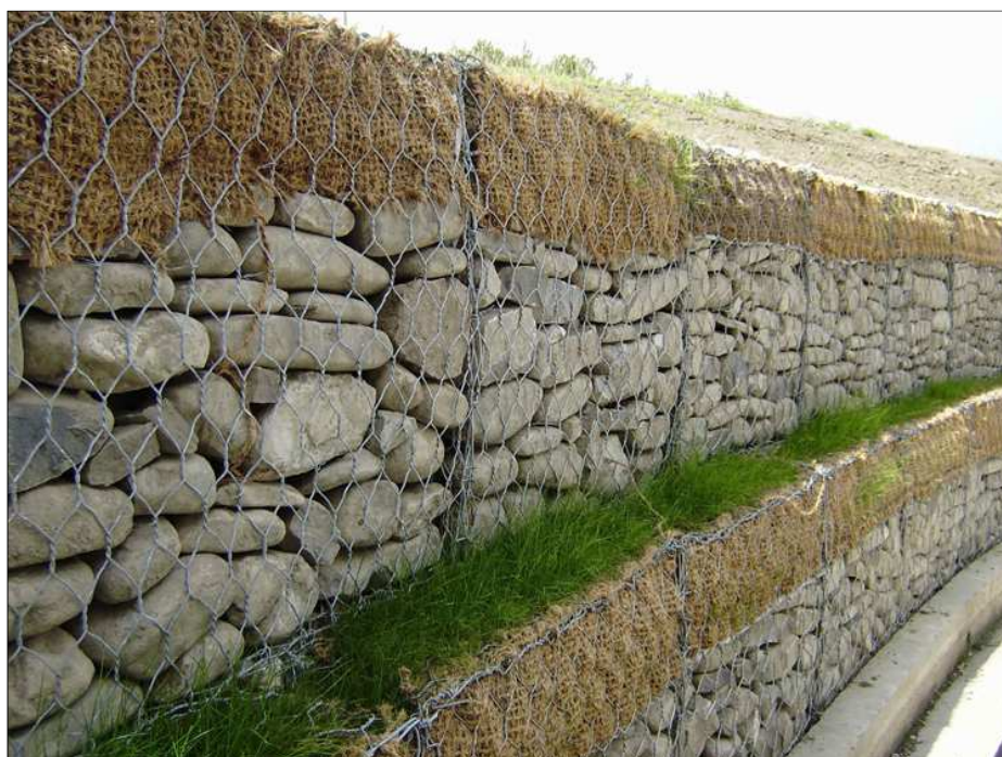
Figura 20: Esempio di opera di contenimento in gabbioni.
