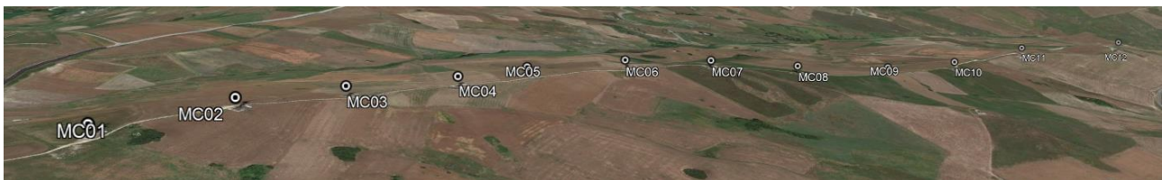
Fig. 1g: Inquadramento del sito Area Sud: Macchia- vista da Nord Ovest
