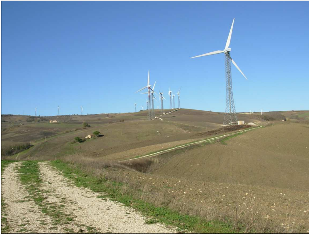
Figura 2: Vista dell'area sud del sito, crinali sviluppo direzione sud- sud-est
