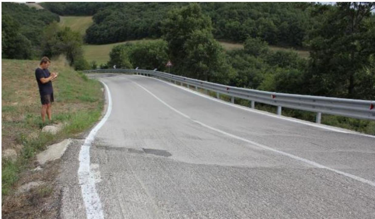
GPX\_09: Panoramica scattata verso valle lungo la SS212 ad inquadrare la sede stradale al di sotto del versante ripreso nel precedente punto di scatto GPX\_08. Si evidenzia un avvallamento della sede stradale, con lesione delle canalette di scolo nel lato di monte della SS212. In questo settore i cavidotti dovrebbero da progetto passare nel versante a monte della SS212 (Agosto 2018).
