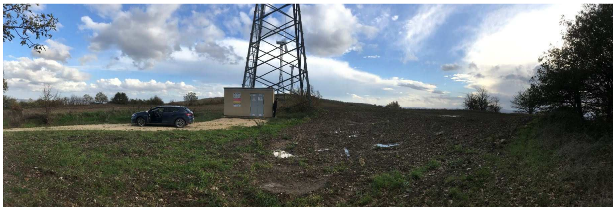
Figura 7.11- Panoramica scattata a Nord della torre eolica esistente MN12. Nel settore pianeggiante fra la MN12 ed il punto di scatto ha sede da progetto l'aerogeneratore R-MN05 (Novembre 2018). Vedi Allegato B il punto di scatto GPX_48b.
