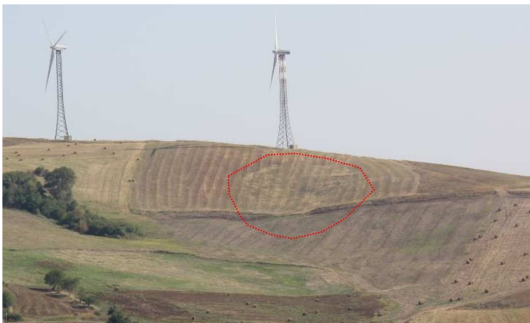
Figura 7.18- Panoramica verso monte (Nord) scattata dalla strada di accesso al parco eolico esistente ad inquadrare i versanti a valle dei settori di crinale prescelti da progetto per l'ubicazione del nuovo aerogeneratore R-MC03 subito a destra dell'ultimo traliccio inquadrato in foto (Agosto 2018). Poco a valle di questo si intuiscono nei campi coltivati morfologie probabilmente legate a fenomeni di soliflusso. Si evidenzia la completa assenza di una rete di drenaggio delle acque meteoriche superficiali nei pendii interessati dalle coltivazioni, probabile causa di questi fenomeni. Vedi Allegato B il punto di scatto GPX_43.
