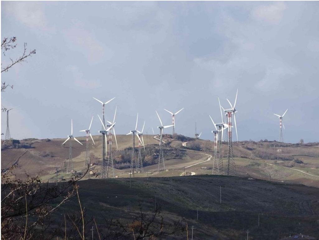
Figura 2.2 – Vista del sito di impianto
