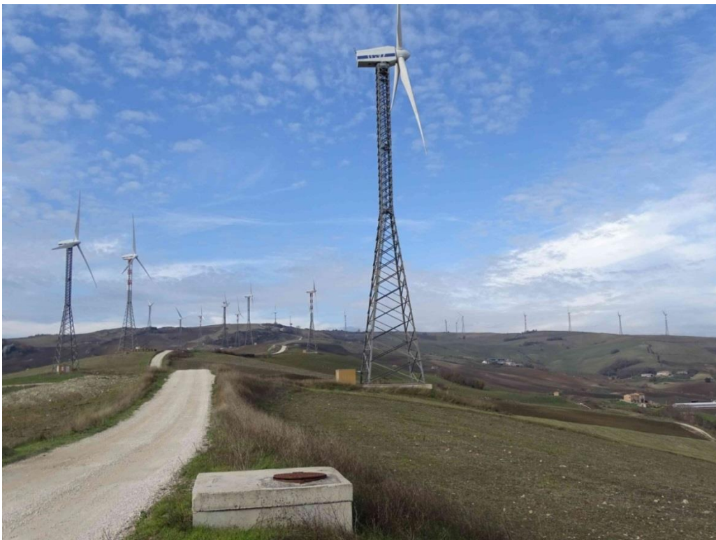
Figura 2.3 – Vista ravvicinata del sito di impianto
