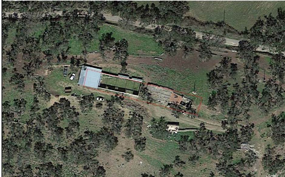
R103 NON ACCESSIBILE ( NON ABITATO, vecchio ovile/deposito/fienile) DISTANZA AEROGENERATORE 100 metri
