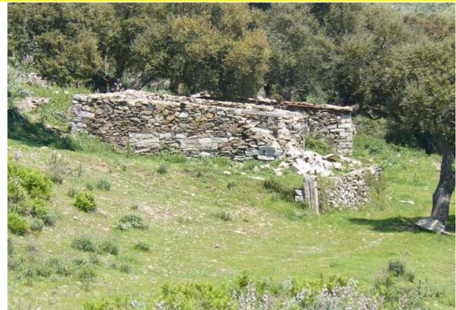
R053 (NON ABITATO, vecchio ovile/deposito/fienile) DISTANZA AEROGENERATORE 100 metri
