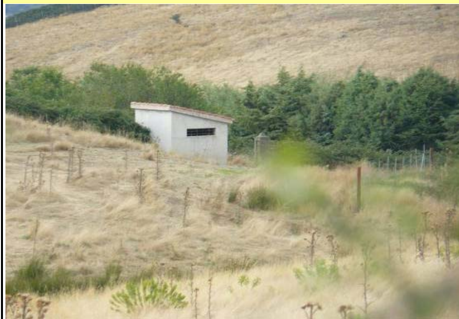
R010 POZZO + VASCONE IDRICO DISTANZA AEROGENERATORE 50 metri
