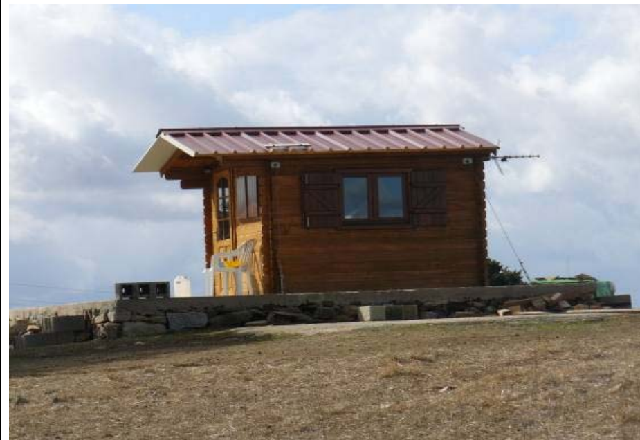
R075 (VEDETTA ANTINCENDIO)
