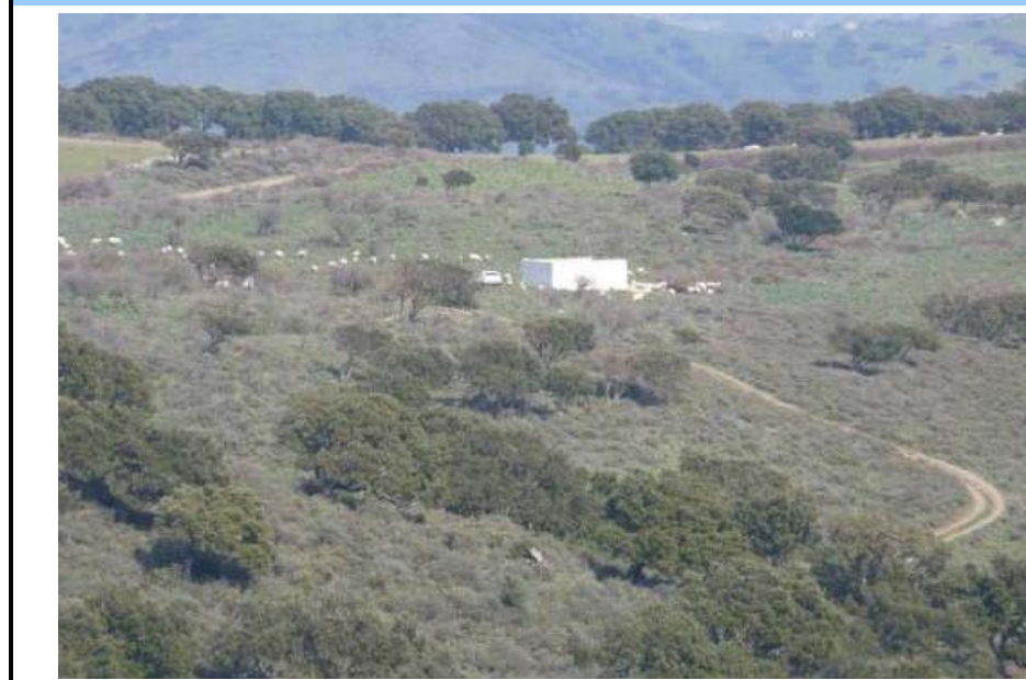
R061 ( NON ABITATO, Vascone Antincendio) DISTANZA AEROGENERATORE 350 metri
