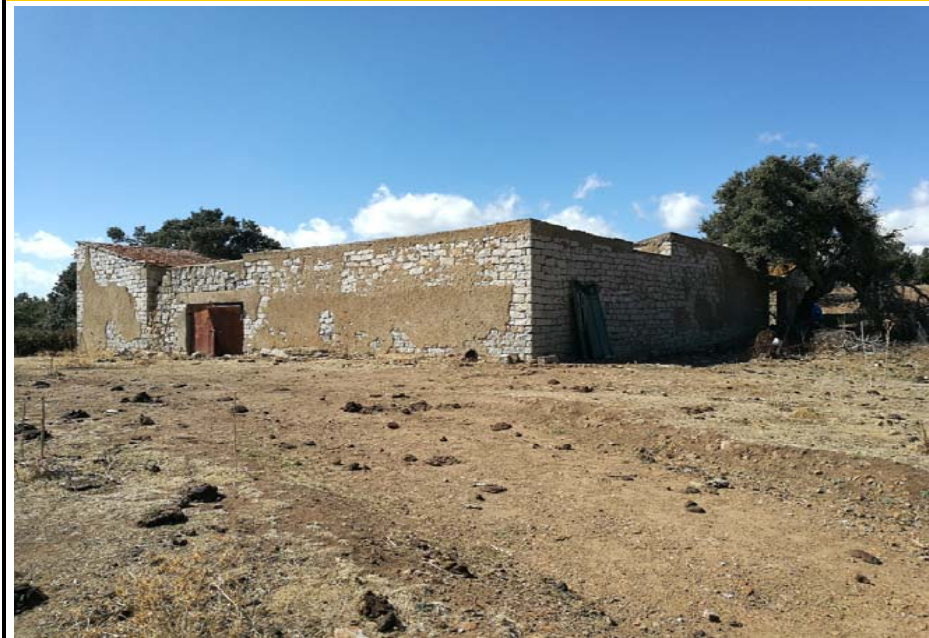
R087 - NON ACCESSIBILE - Corpo aziendale ad utilizzazione agro-pastorale -RUDERE - DISTANZA AEROGENERATORE 100 metri
