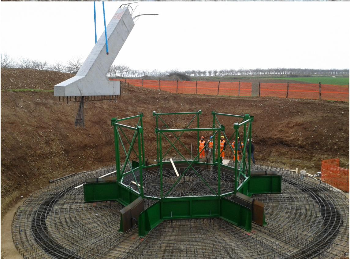
Figura 7 - Diverse fasi della realizzazione della fondazione
