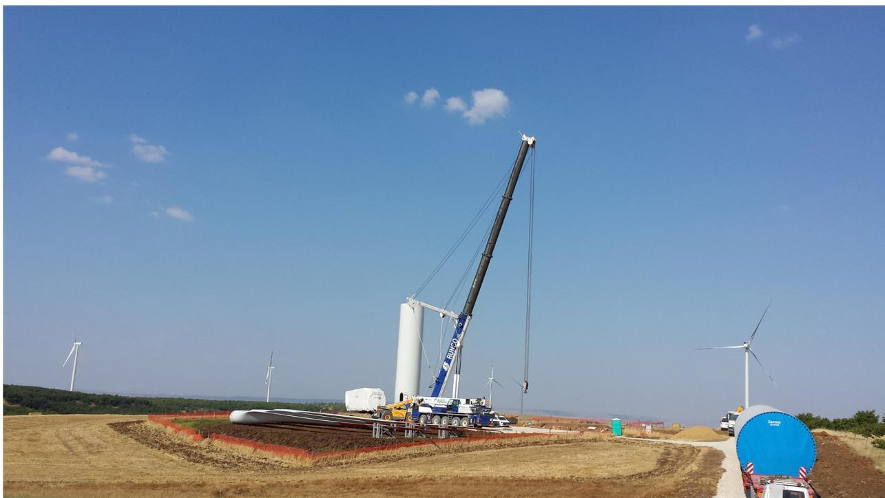
Figura 1 - fase di montaggio della torre. Sono visibili l'area temporanea di stoccaggio dei vari componenti dell'aerogeneratore
