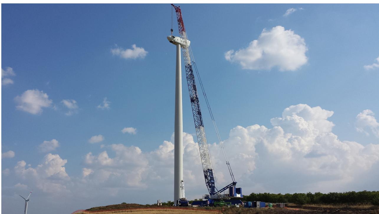
**Figura 3 - Montaggio navicella con l'ausilio di due gru**
