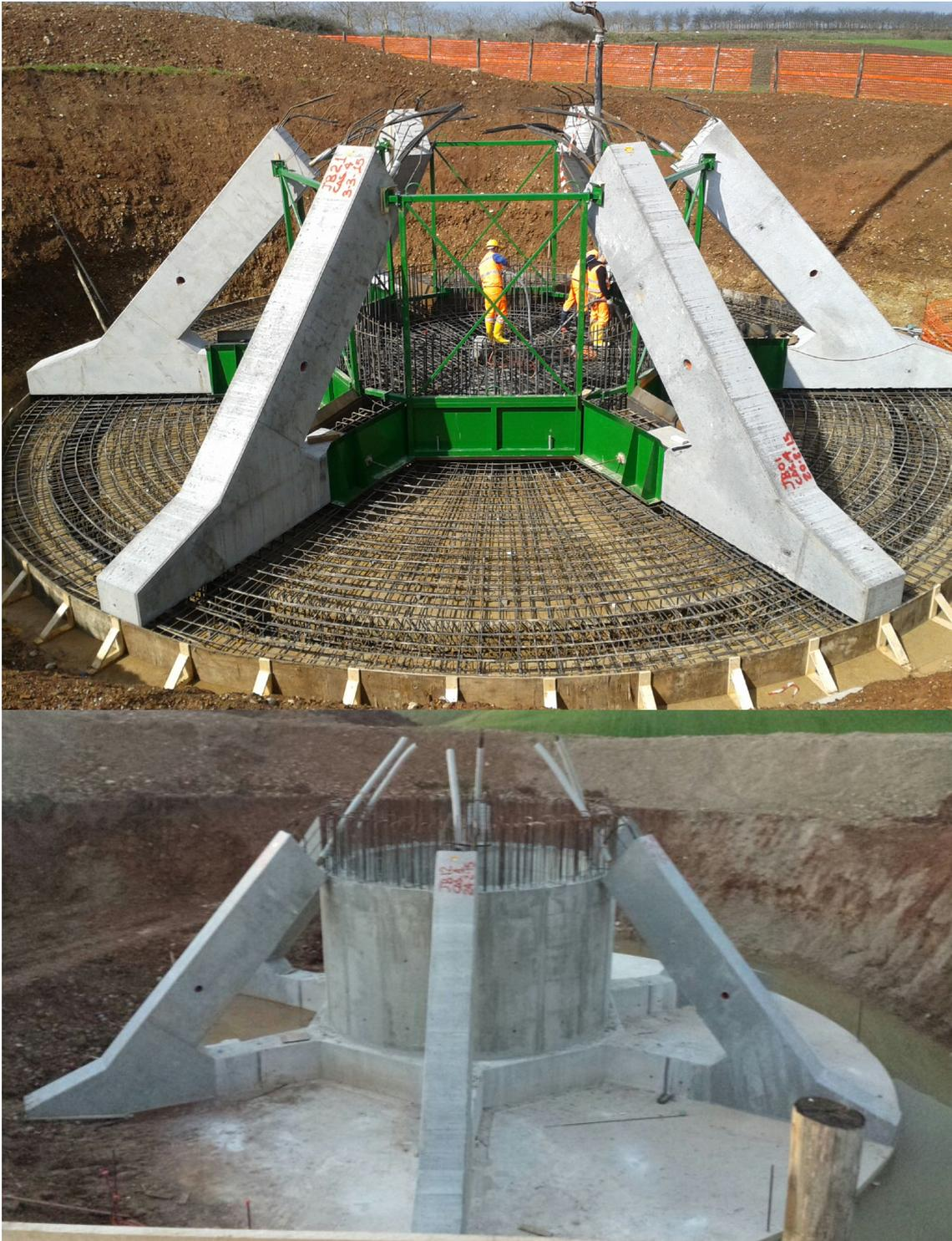
Figura 8 - Diverse fasi della realizzazione della fondazione
