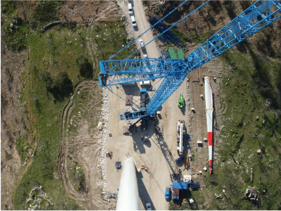
Figura 9 - fase di sollevamento delle pale. E' visibile anche la piazzola e le aree di stoccaggio temporanea
