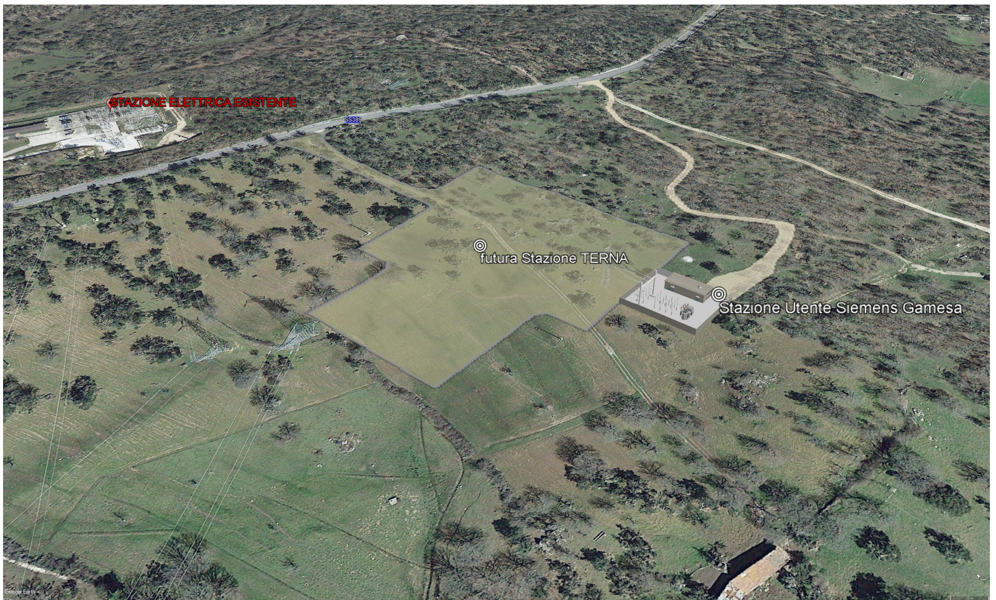
Figura 9 - Render con stazione utente Siemens Gamesa e area ingombro futura stazione TERNA
