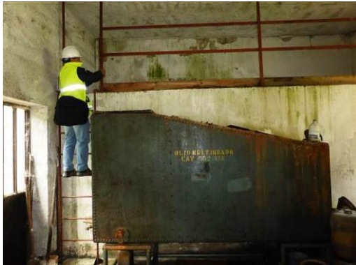
Rifiuti deposito olii
