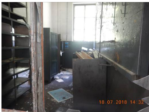
Rifiuti vari vano officina
