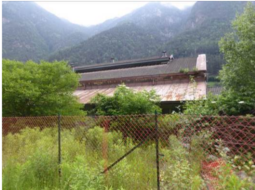
Copertura Deposito locomotive
