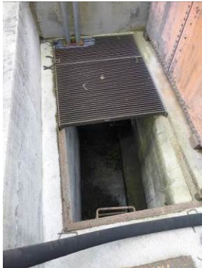
Botola di accesso alla vasca interrata
