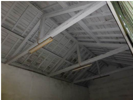
Vista interna del tetto in legno
