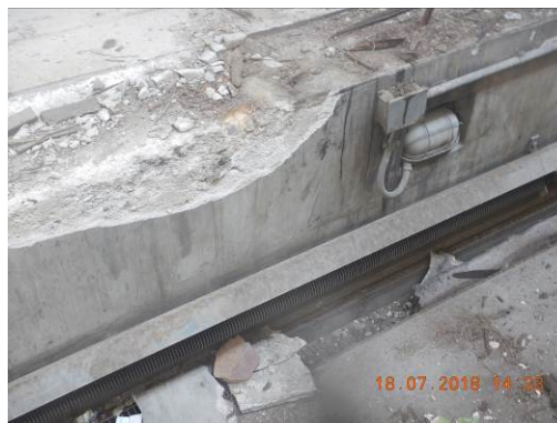
Particolare fosse Rimessa
