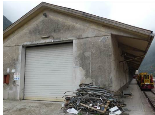
Edificio – Gebäude “A5”
