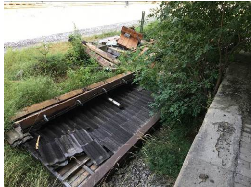
Porzione di copertura in legno e tegole
