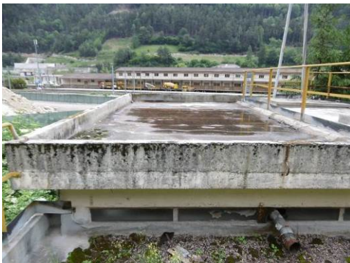
Copertura edificio "A7" – Dach Gebäude "A7"
