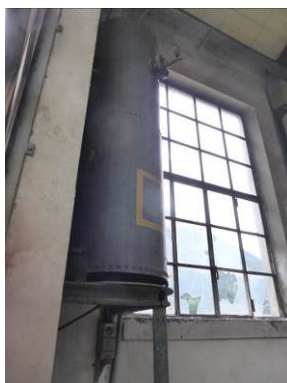
Serbatoio presente nella Rimessa
