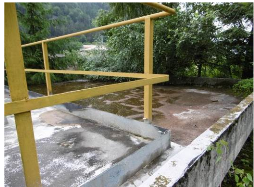
Copertura edificio "A7" – Dach Gebäude "A7"
