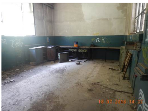
Rifiuti vari vano officina
