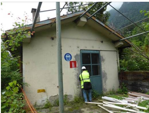
Edificio Gebäude „A6“ – Rifiuti esterni
