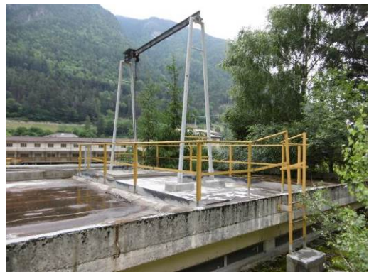
Copertura edificio "A7" – Dach Gebäude "A7"
