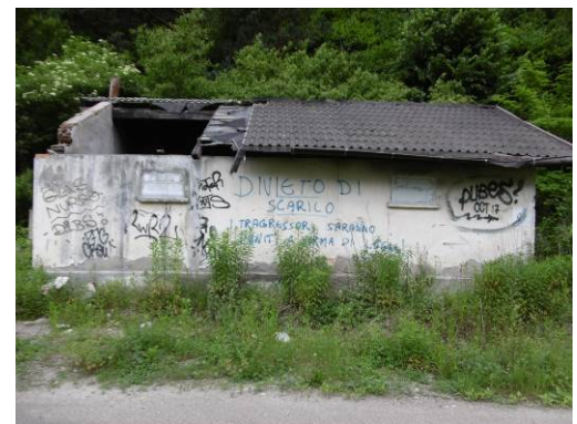
Copertura Edificio „A4“
