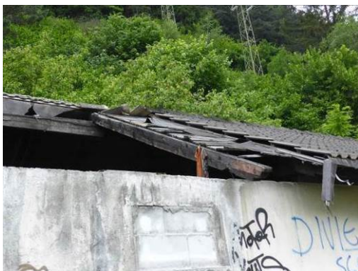
Copertura Edificio „A4“
