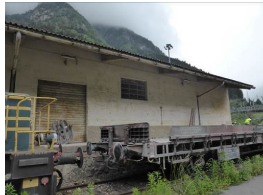
Edificio – Gebäude “A5” con binario tronco lato interno ferrovia
