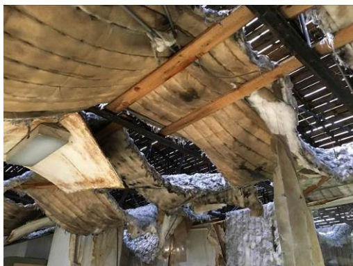
Copertra tetto con materassini isolanti
