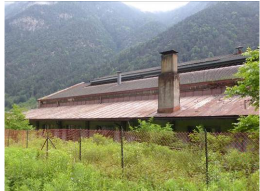
Copertura Deposito locomotive
