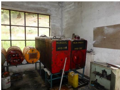
Rifiuti deposito olii
