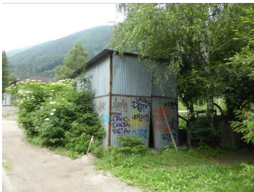
Baracca - Barackenlager „A8“
