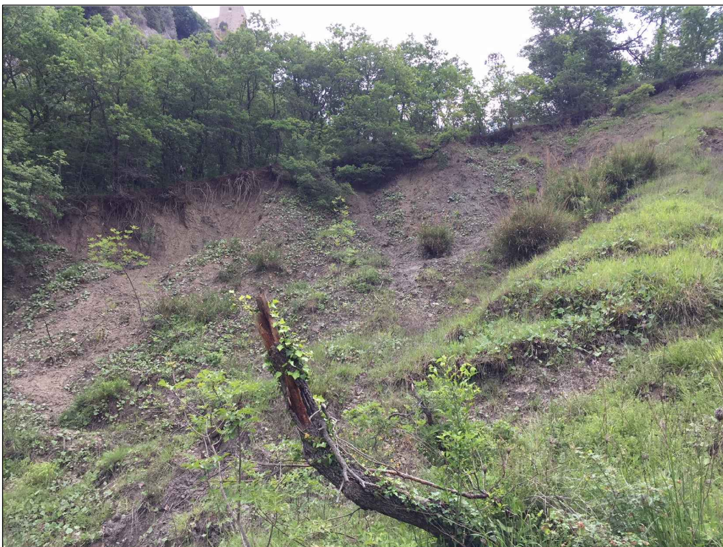
Dissesto che interferisce con la condotta in esercizio in corrispondenza del quarto ambito di intervento
