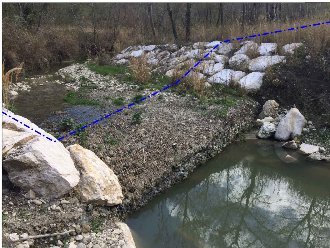
Panoramica del tracciato da mantenere in esercizio in corrispondenza del primo ambito di intervento
