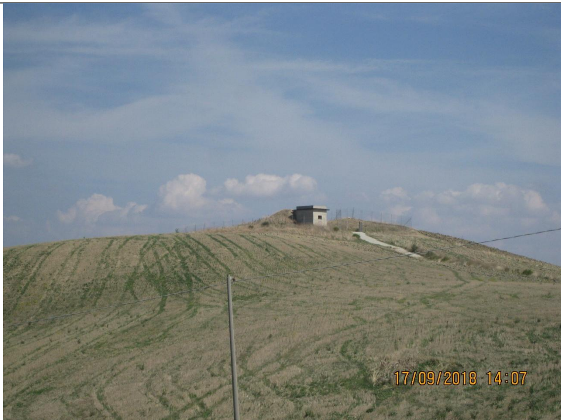
Sito di localizzazione Aerogeneratore Acr04 – Stato dei luoghi.
