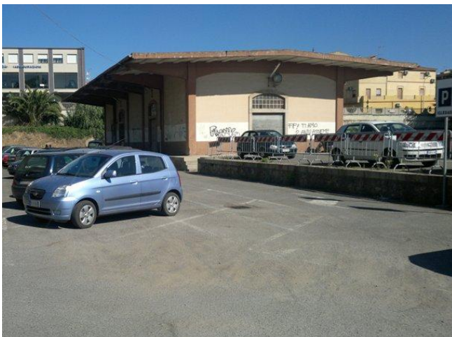
Ex magazzino da ristrutturare
