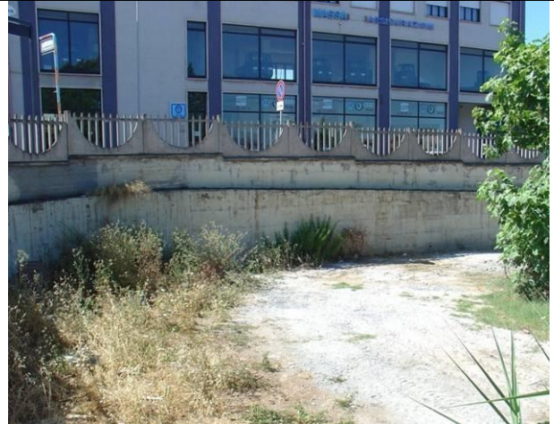
Muro interno sulla Via XX settembre
