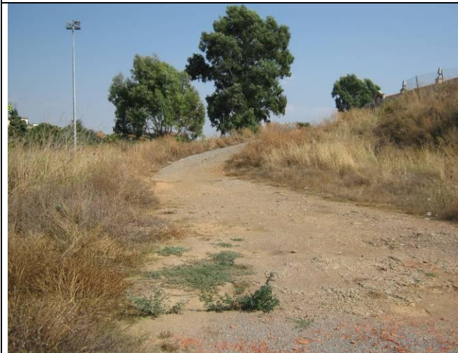
Area nuova strada di accesso
