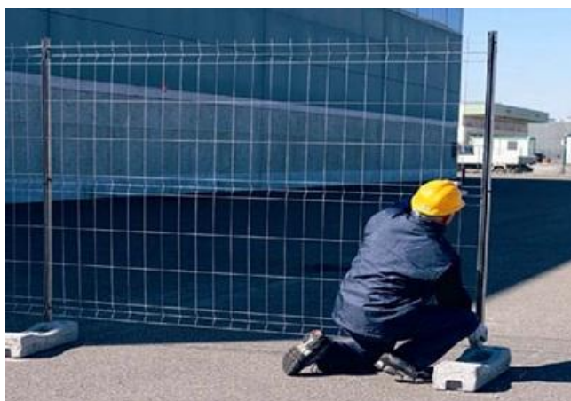
Recinzione metallica di cantiere e telo di protezione
