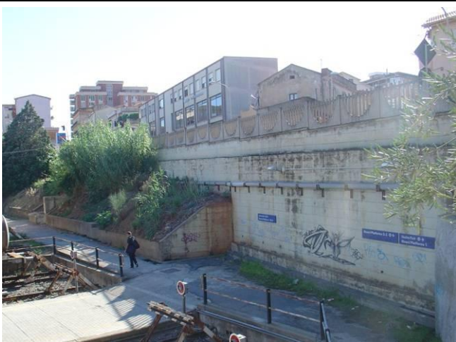
Muro di contenimento interno su Via XX settembre
