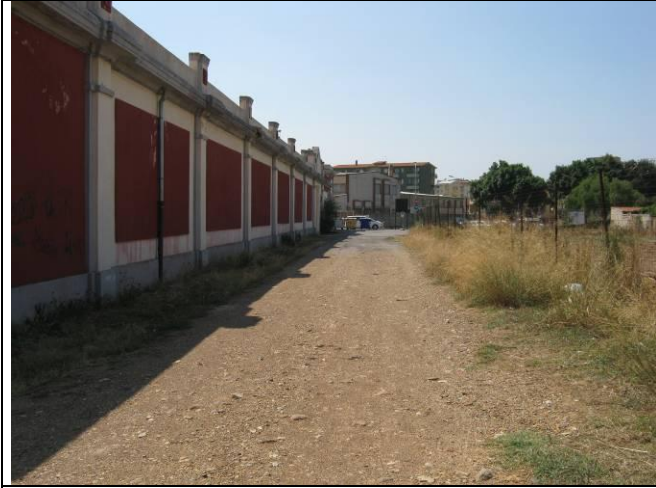
Area nuova strada di accesso
