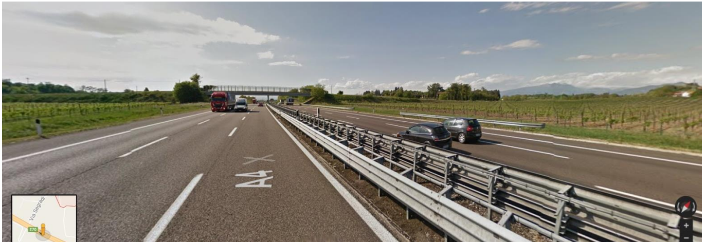
Figura 1.1 - Galleria San Giorgio in Salici – Vista del tracciato della Autostrada A4, nel tratto interferito dalla futura Galleria Naturale (sullo sfondo il cavalcavia via Segradi).
