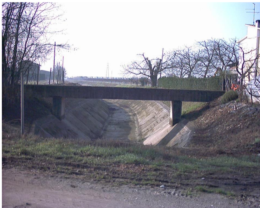
Figura 2 - Ponte-canale esistente (Canale 6)
