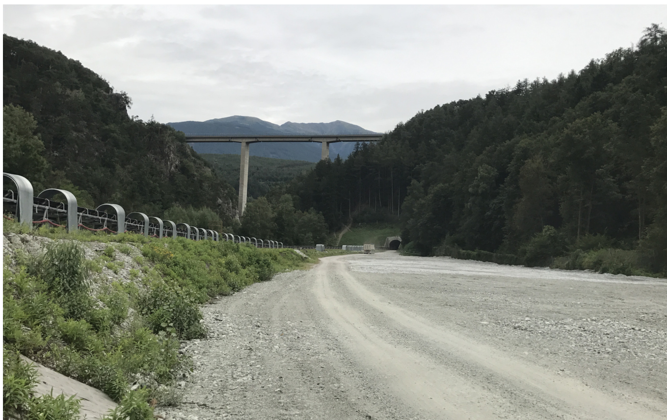
Figura 2. Ripiano di base adiacente al fiume Isarco attualmente sede del cantiere BBT
