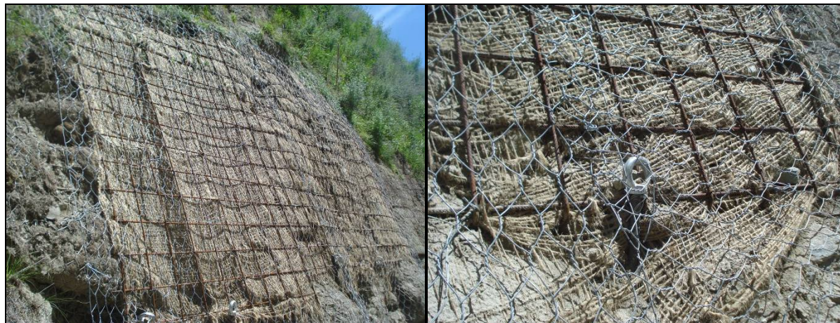
Figura 9. Interventi di manutenzione dopo danni dovuti ad impatto
