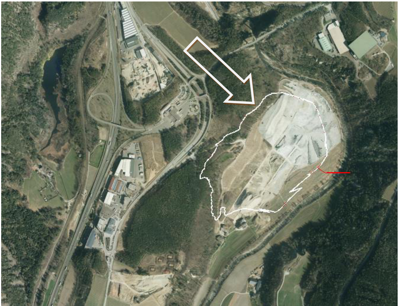
Figura 1. Ubicazione deposito di Hinterrigger
