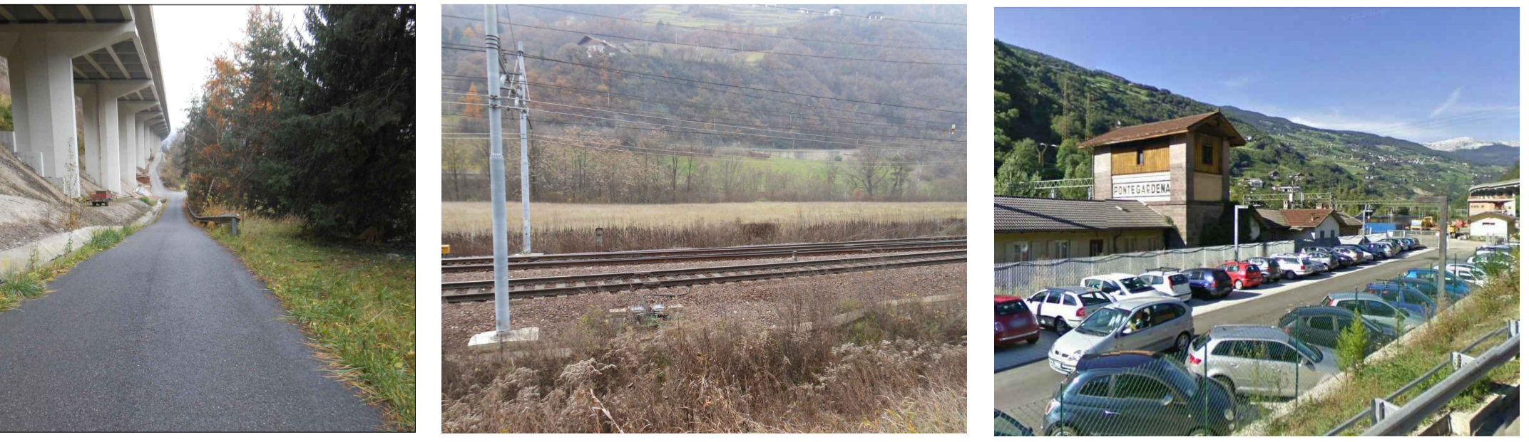
FOTO 3 - STRADA DI ACCESSO AI CANTIERI (LATO NORD) FOTO 2 - VISTA DELL'AREA DESTINATA AL CANTIERE OPERATIVO C.O.06A FOTO 1 - VISTA DEL CANTIERE BASE C.O.06B
