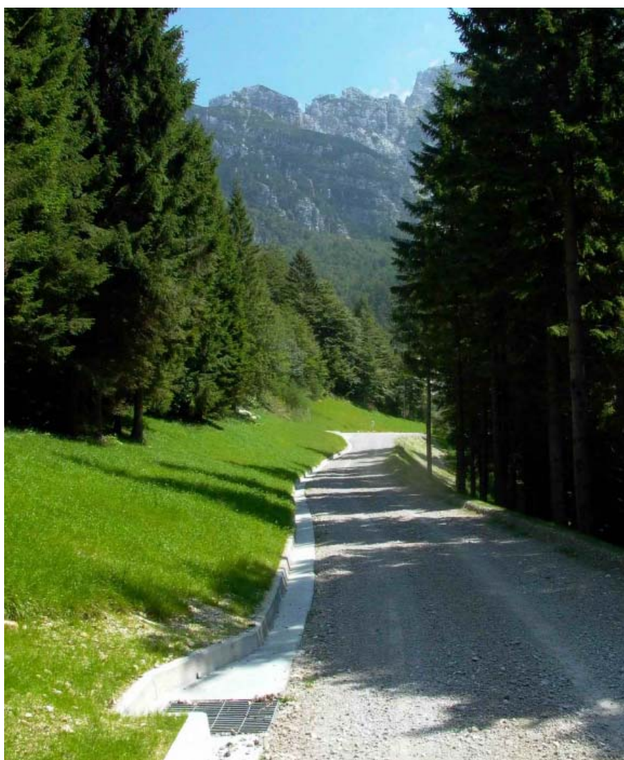
Foto 7.2/D: Ripristino morfologico e vegetazionale in corrispondenza di un metanodotto di recente realizzazione; osservando l'immagine, la condotta è posata lungo il margine sinistro della sede stradale (giugno 2001).
