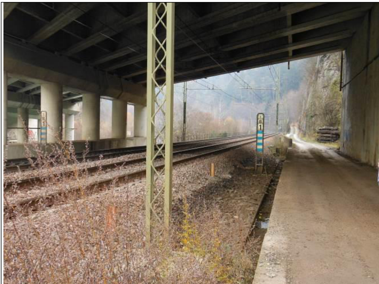
Strada di servizio delle ferrovie in affiancamento della linea ferroviaria. Punto in corrispondenza del cavalcavia autostradale A22.
