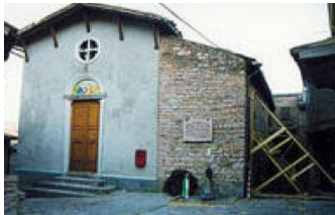
Figura 6.1 – Esempio di sistema di puntelli inclinati esterni
