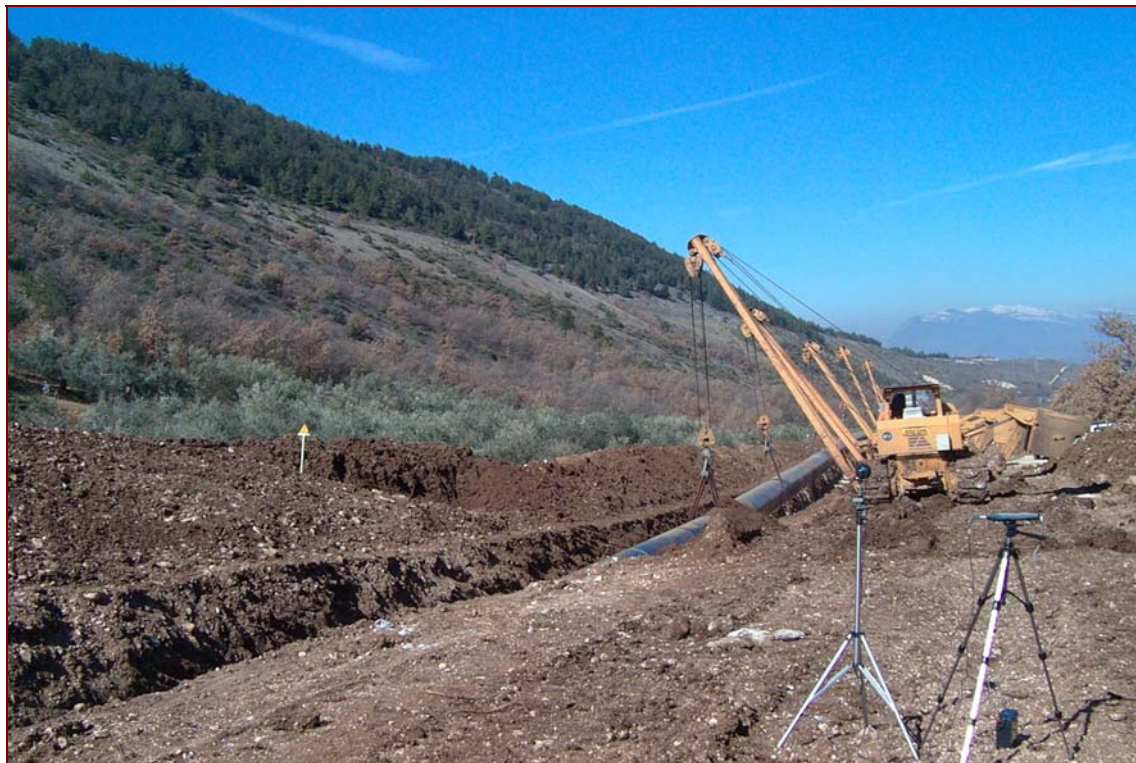
Figura 4.2/A: Rilievi acustici durante l'operazione di posa della condotta
