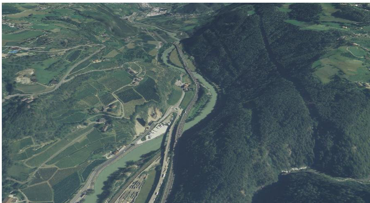
Figura 5-6 – Vista aerea da sud della valle di Funes. Fonte: Ambiente Italia 3D.
