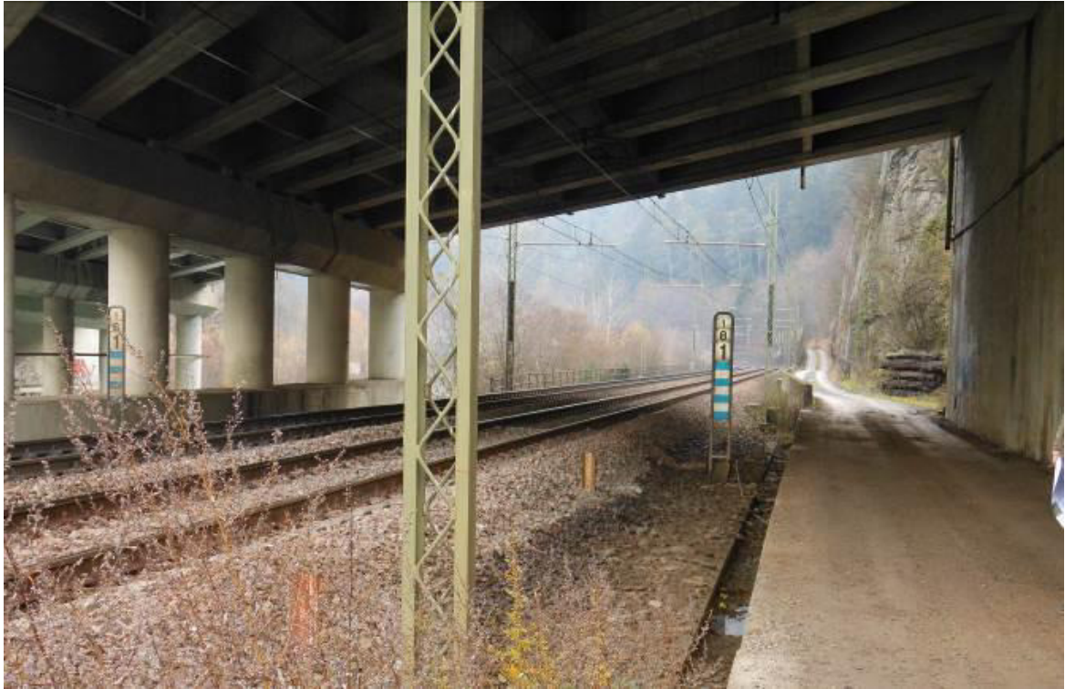
Strada podereale da adeguare per accesso all'area di stoccaggio A.S.03A
