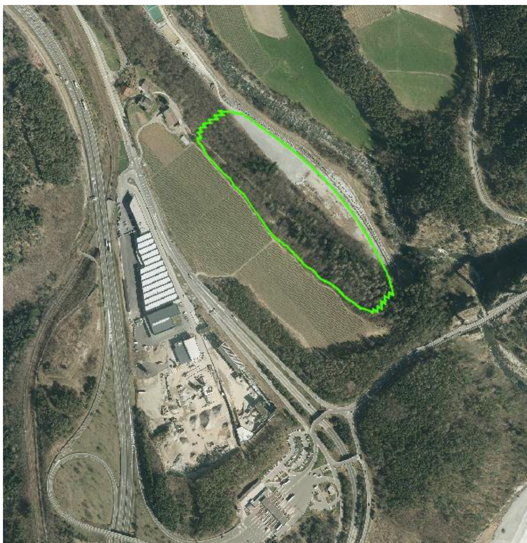
Figura 3-13 – Fotoaerea con la perimetrazione del deposito di Plattner in verde
