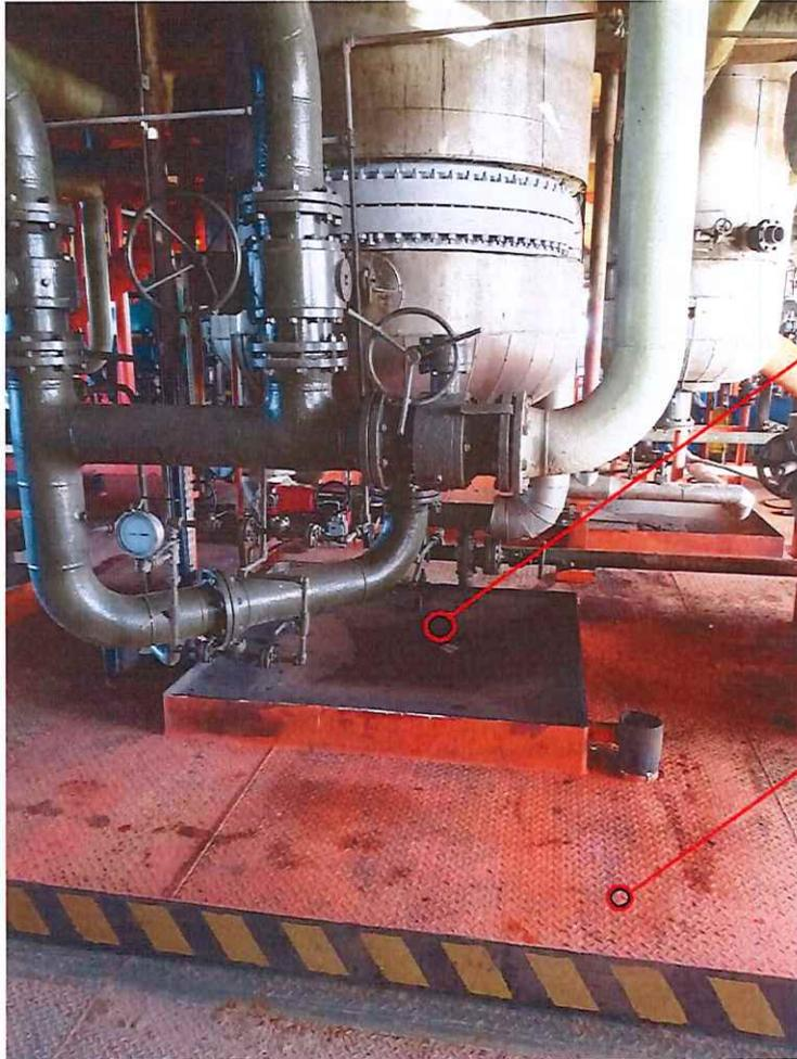
Sistema di raccolta di eventuali versamenti provenienti dalle apparecchiature di processo (aree con possibile contaminazione da sostanze pericolose)
