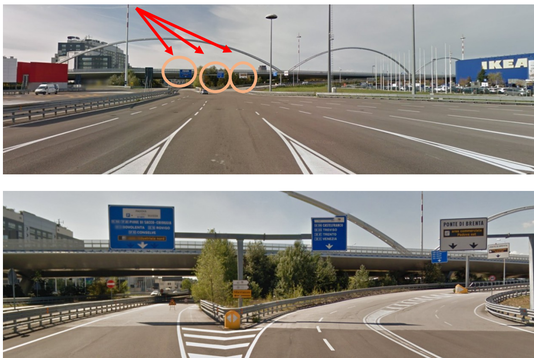
Figura 13 – Segnaletica verticale dopo la barriera per istradamento verso le tre direttrici
