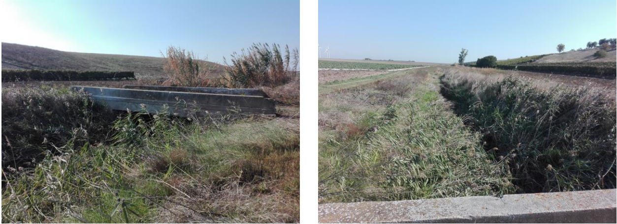
Foto nn. 3,4 – Vista da valle dell’attraversamento sul canale San Leonardo
