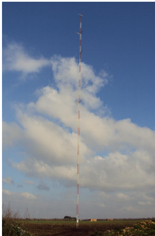
Figura 4: Vista dell'anemometro installato in località Posticciola, Comune di Stornara
