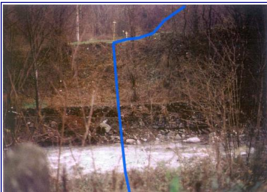
Rappresentazione fotografica dell'alveo a monte del sito di attraversamento (metanodotto esistente)
