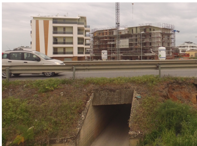
Foto 7: Criticità riscontrate agli arginelli
