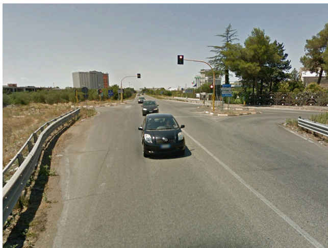
Foto 3: Intersezione tra SS. 96 e S.C. "Via Graviscella"
