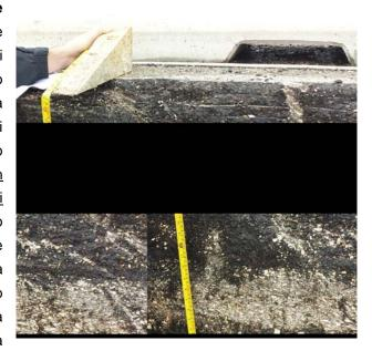
regolarizzazione delle pendenze trasversali mediante una fresatura profonda (11 cm) e la formazione di una nuova pavimentazione stradale così composta:
