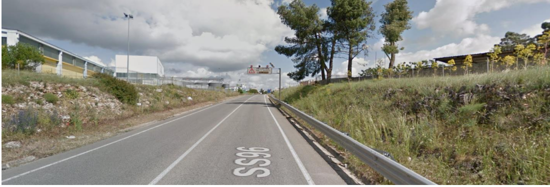
Inizio intervento Km 78+000 (Sez.1 di progetto)
