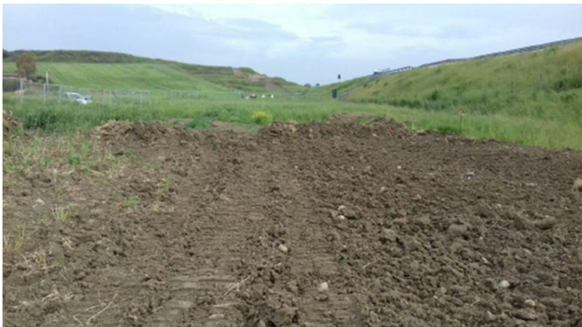
INP 200B – Scotico e recinzioni di cantiere
