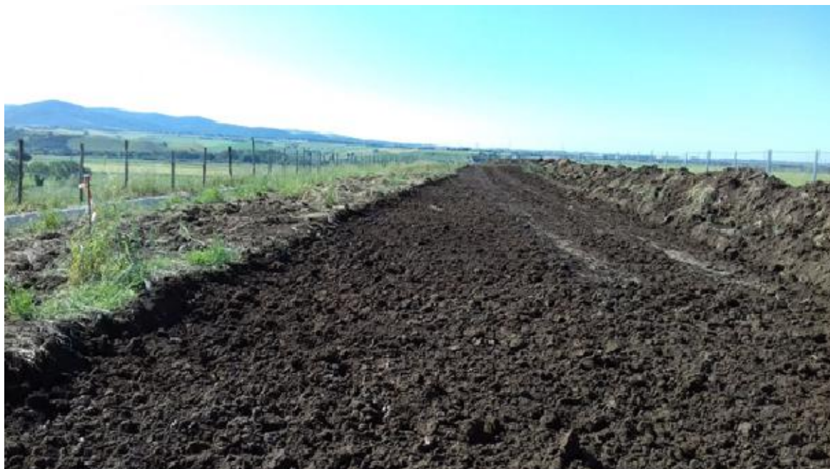
INP 200A – Scotico e recinzioni di cantiere
