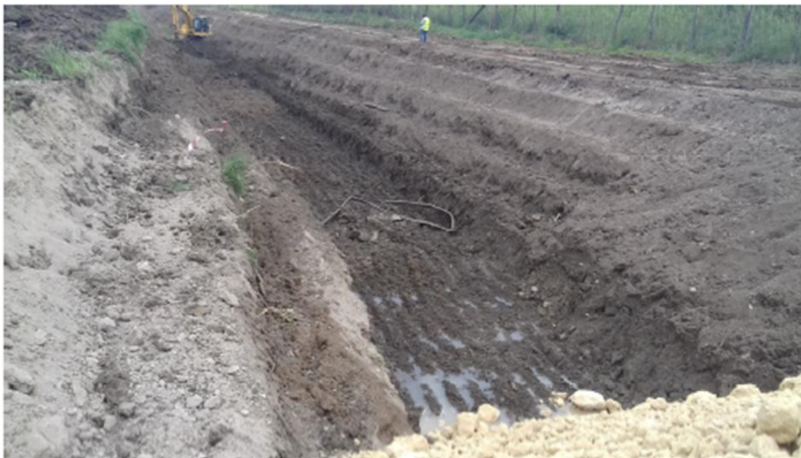
INP 200B – Scotico, ammorsamento scarpate, scavo di bonifica e recinzioni di cantiere
