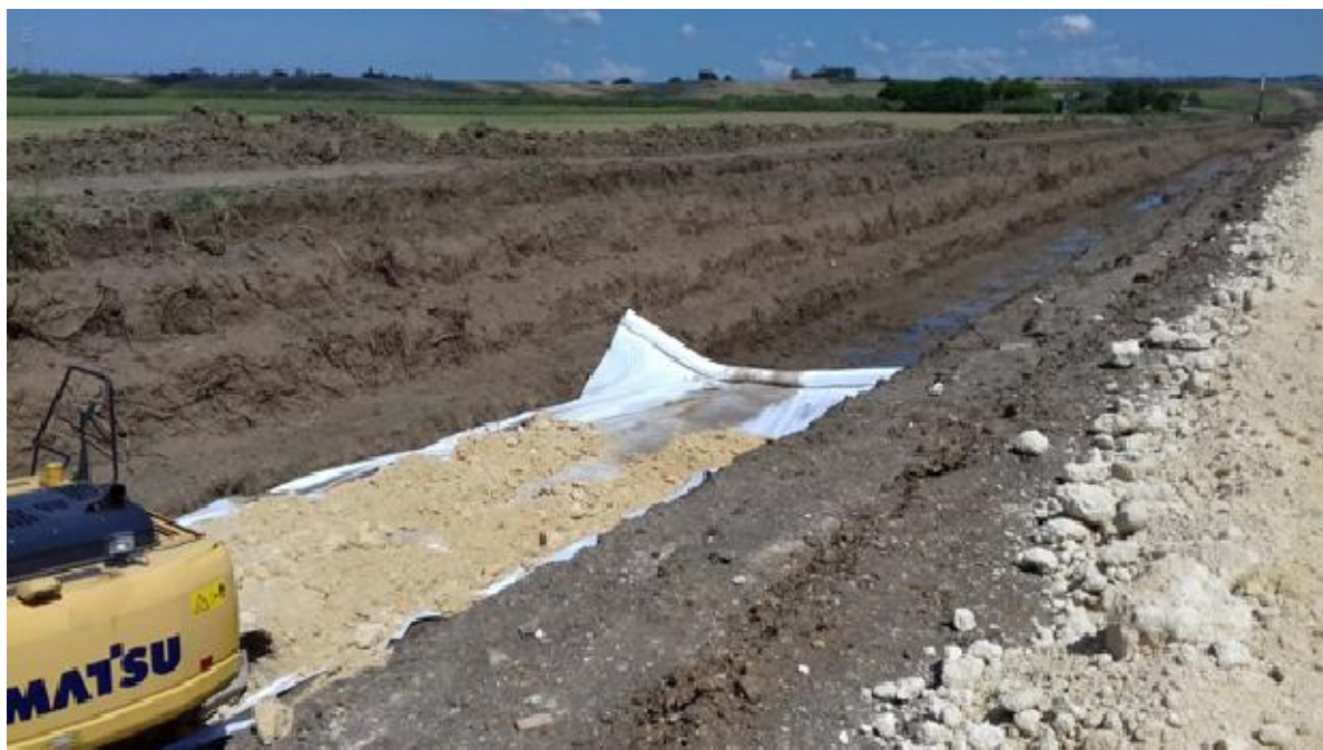
INP 200B – Scavo di bonifica, ammorsamento scarpate tra sez. 38 e sez. 61
