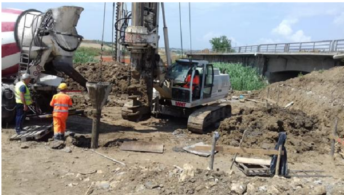
VIP03 – Spalla B - Esecuzione pali di medio diametro
