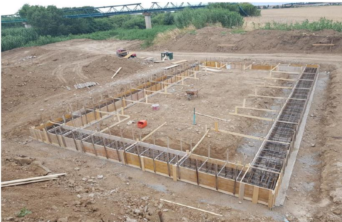
VIP03 – Armatura cordolo di testa Pali di medio diametro Spalla A
