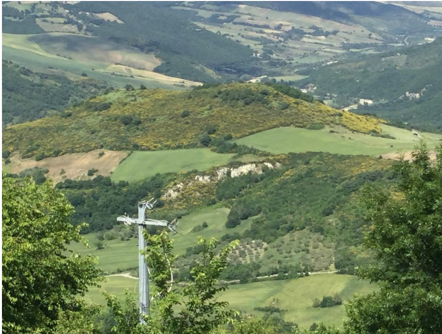
Figura 2-5. Vista dei movimenti franosi che interessano l'impluvio a NE di Panni, a monte dell'imbocco nord-orientale della galleria "Hirpinia"
