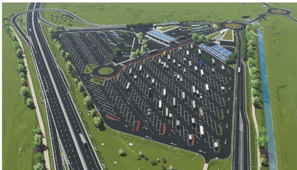
Figura 13: Vista generale dell'autoporto e del sistema di accessi all'autoporto dalle infrastrutture
