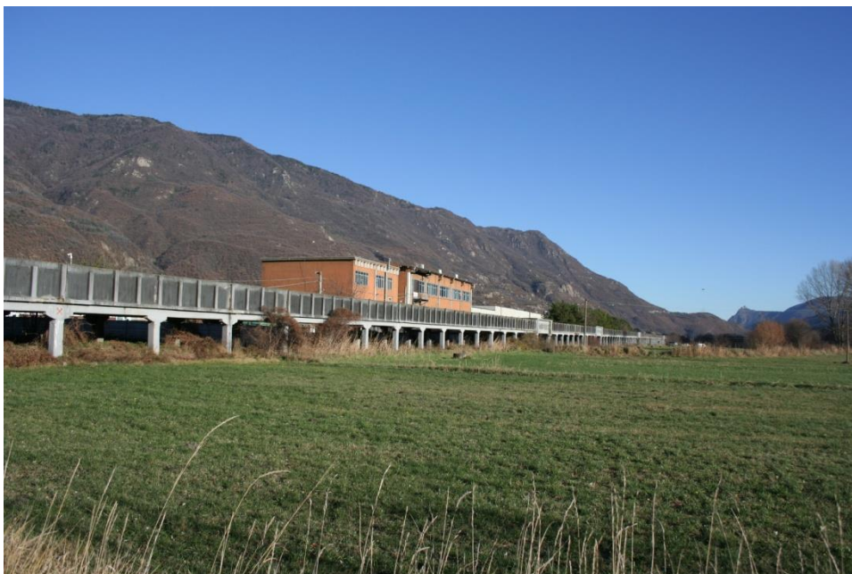
Figura 12 - Tratto di canale NIE sopraelevato in comune di Bruzolo
