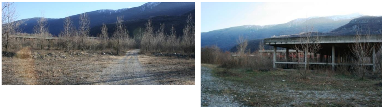
Figura 8 - Area destinata all'autoporto con edifici incompiuti in stato di abbandono e vegetazione in evoluzione
