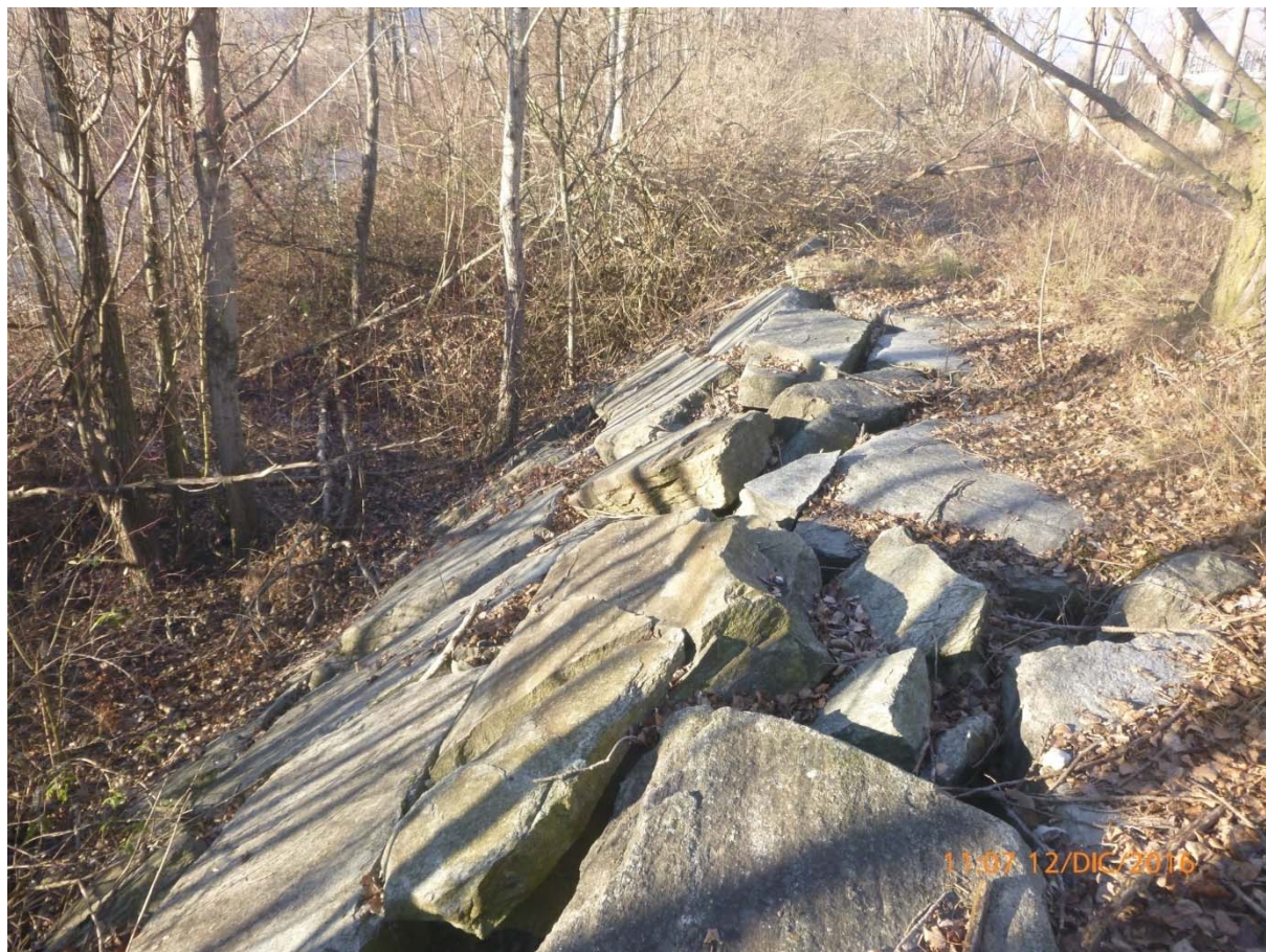
Figura 7 – Mantellata antierosiva sul rilevato arginale.
