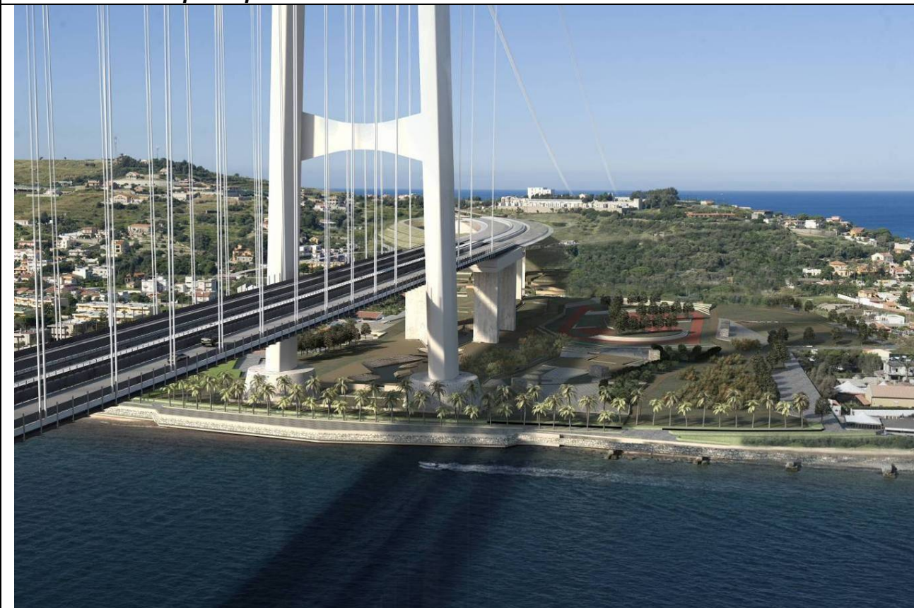
Fig. 10.2b - Opera analizzata: Ganzirri - Ponte Area di attacco a terra e Viadotto Pantano Confronto ante e post operam
