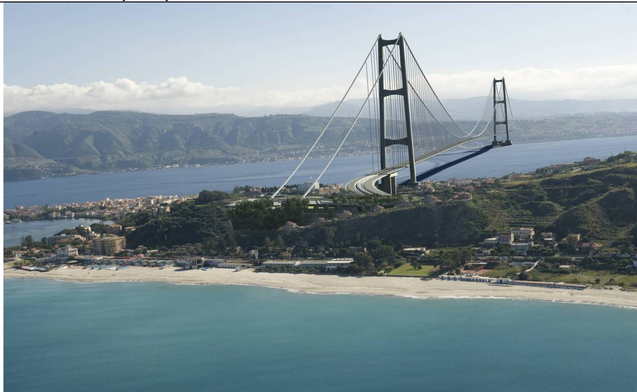
Fig. 10.3.b - Opera analizzata: Granatari - Blocco di ancoraggio Vista da Mortelle Confronto ante e post operam
