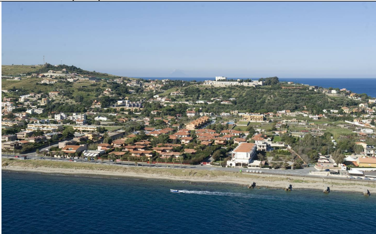
Fig. 10.2a - Opera analizzata: Ganzirri - Ponte Area di attacco a terra e Viadotto Pantano Confronto ante e post operam
