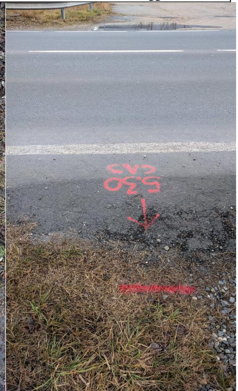
La quota è riferita al livello superiore della tubazione. Durante la fase intermedia di scavo ( circa 40cm ) per la realizzazione della rotatoria , la quota tra la tubazione interrata filo superiore e la quota media della rotatoria sarà all'incirca a - 0,90m.
