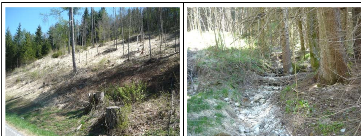
Fig. 12 Area d'imbocco della galleria artificiale e impluvio interferente alla progressiva 00+200 km
