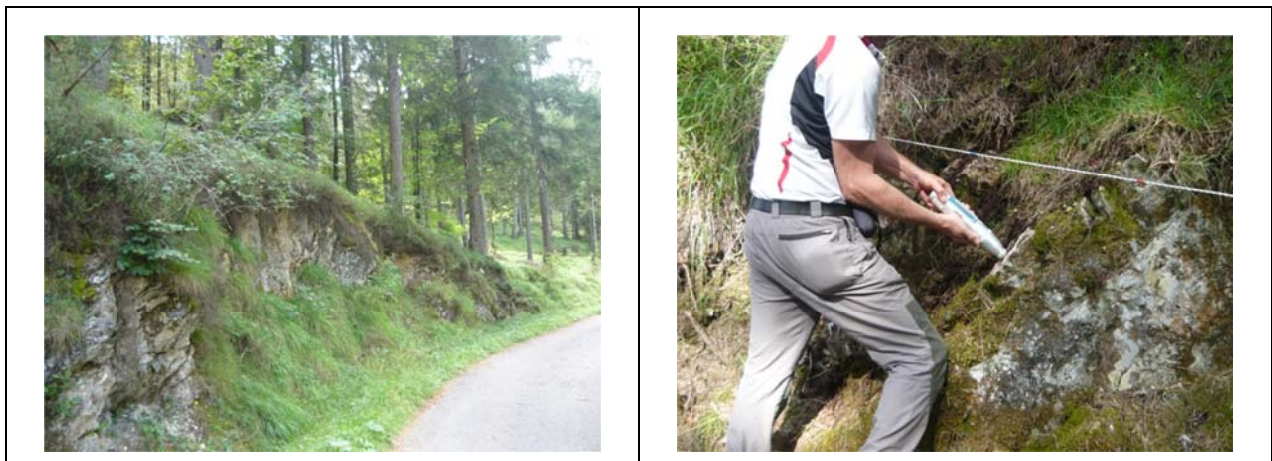
Fig. 14 Stazione di rilievo e misura della resistenza alla compressione con sclerometro
