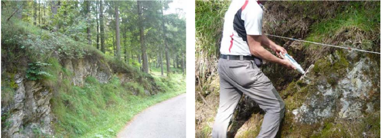
Figura 39 – Stazione di rilievo e misura della resistenza alla compressione con sclerometro
