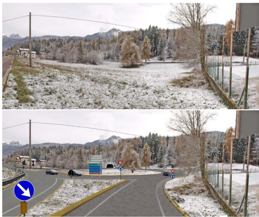
Figura 21 Area di intervento imbocco Nord-Ovest direzione Cortina: foto della situazione attuale e foto con inserimento del progetto
