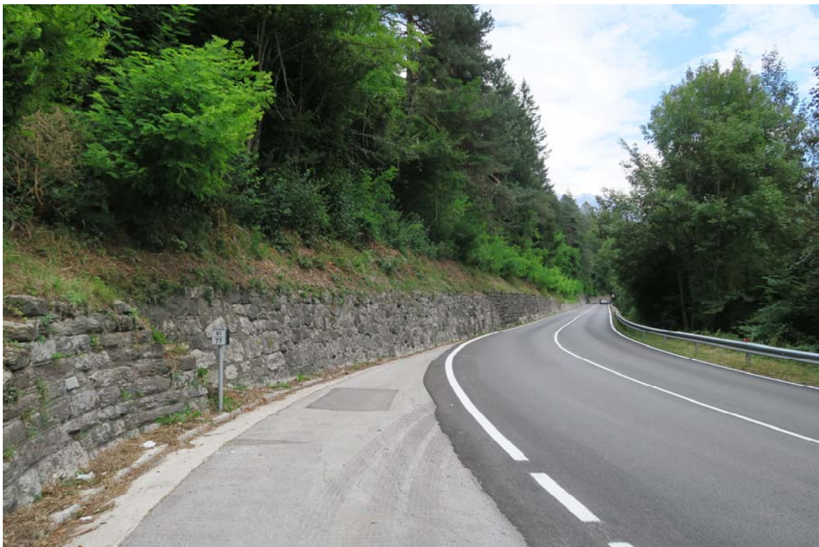
Figura 12. Il versante in corrispondenza dell'innesto in galleria dello svincolo ovest ripreso dal basso, S.S. 51.
