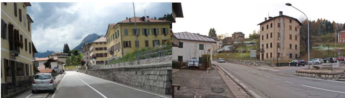
Figura 3 - Viste del tratto di SS 51 che attraversa il centro abitato di Valle di Cadore
