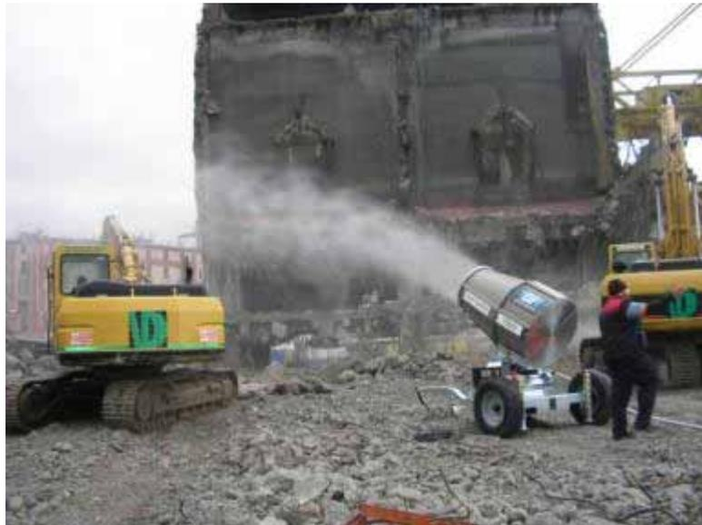
*Figura 27: Nebulizzatore per abbattimento polveri.*
