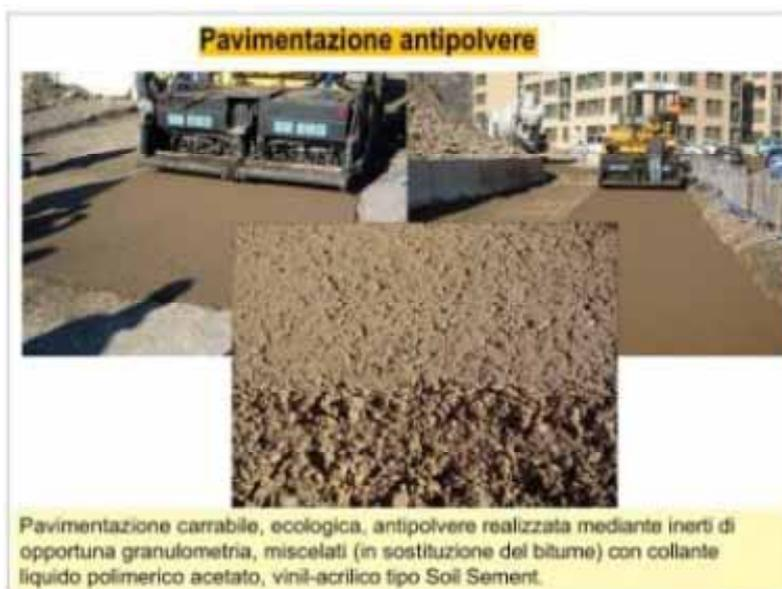
Figura 26: Pavimentazione carrabile ecologica
