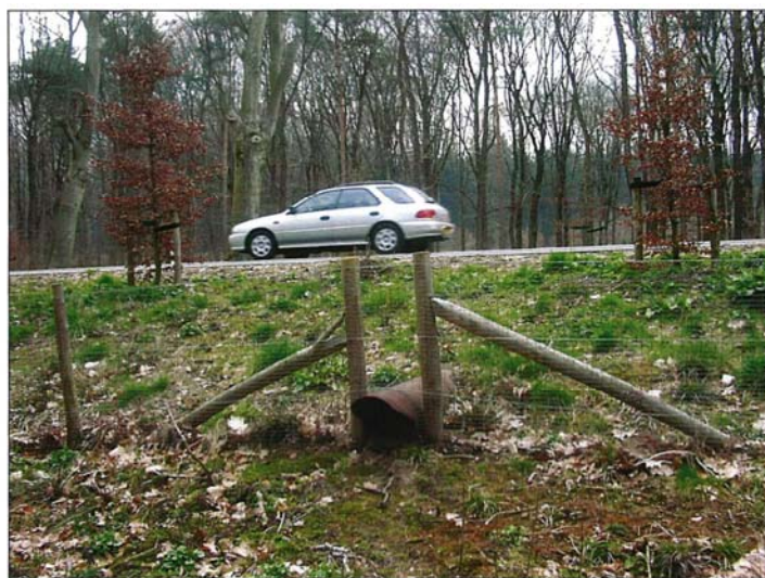
Figura 9: Esempio di sottopasso faunistico (tratto da {Transportation, 2011 #74} ).
