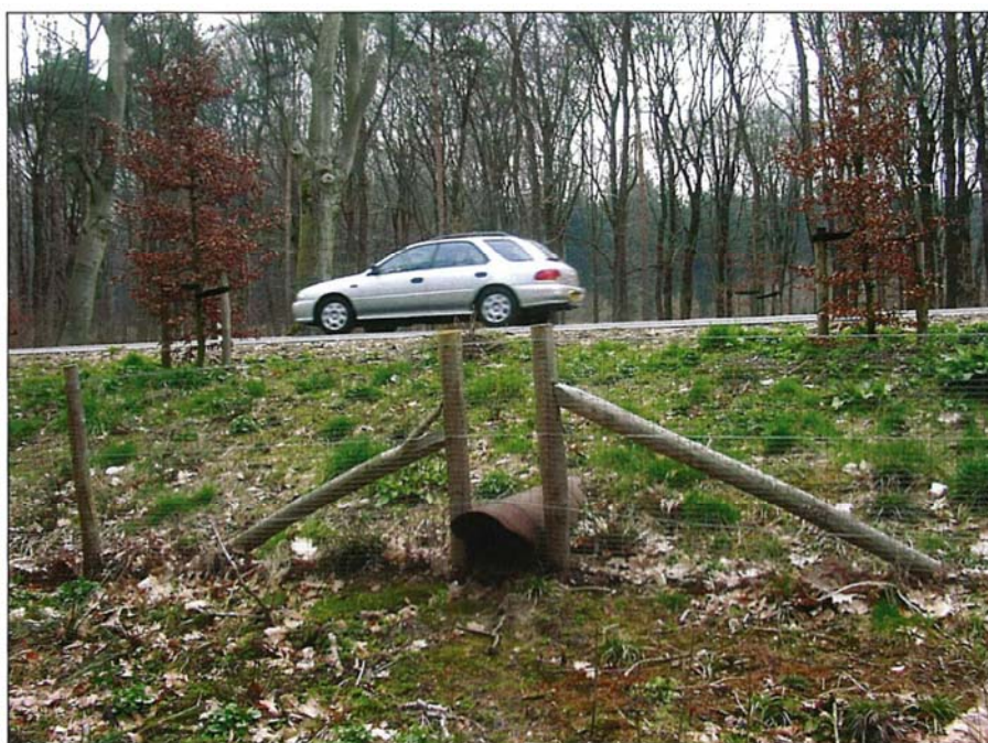
Figura 9: Esempio di sottopasso faunistico (tratto da {{Transportation, 2011 #74}}).
