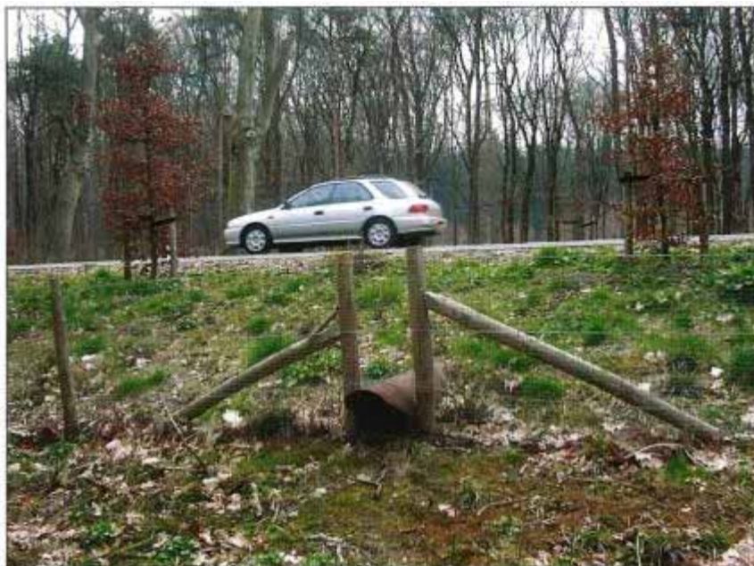
Figura 9: Esempio di sottopasso faunistico (tratto da (Research)).
