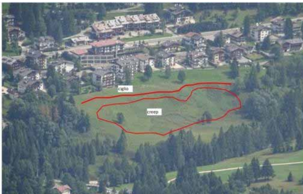
Figura 16: Vista della parte bassa della sponda sinistra del Boite
