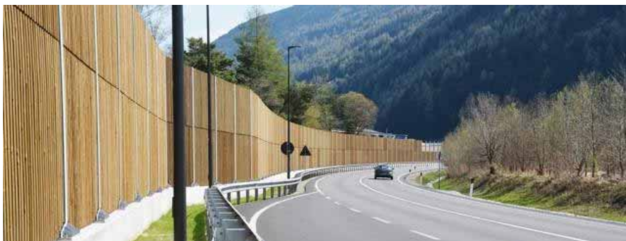
Figura 8: Barriere fonoassorbenti in materiali ligneo.
