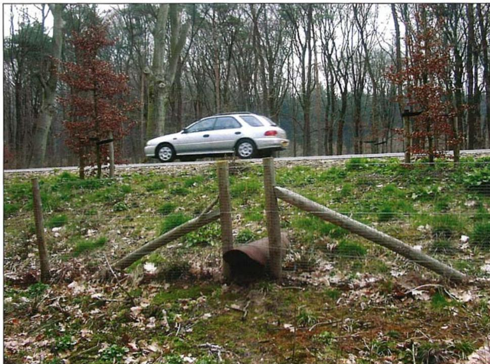
*Figura 49: Esempio di sottopasso faunistico (tratto da {{Transportation, 2011 #74}}).*
