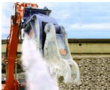
Figura 10: Nebulizzatore per escavatore con pinza demolitrice
