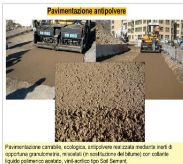
Figura 8: Pavimentazione carrabile ecologica
