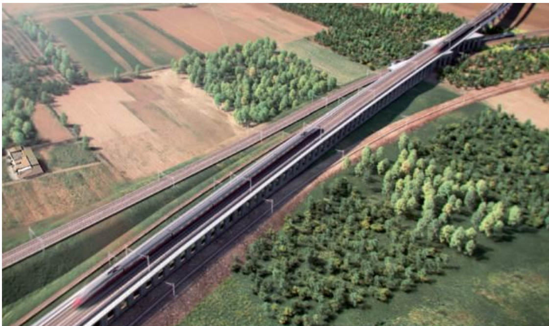
Struttura ad Archi – collegamento scalo Marcianise
